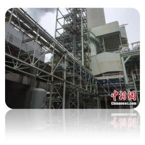
具备兼容设计的胺法碳捕集装置。项目 方供图。
